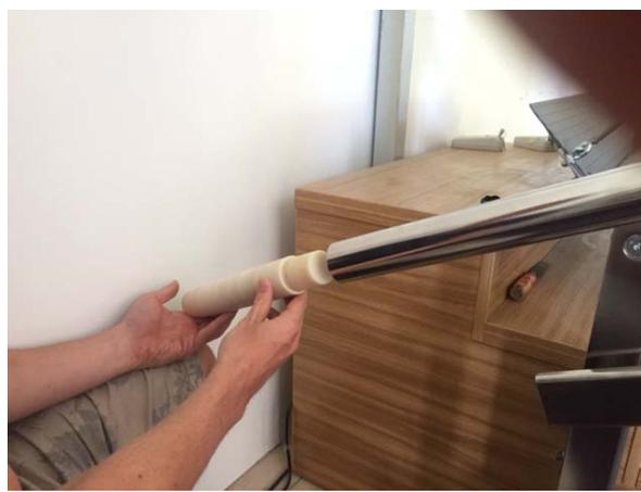
Colocar la plataforma salvaescaleras con la plataforma cerrada en la posición de parada inferior. Una persona sujeta la plataforma salvaescaleras en posición vertical o utilizar un carrito y atar la plataforma a ello tal que queda de pie en la posición de estacionamiento.
